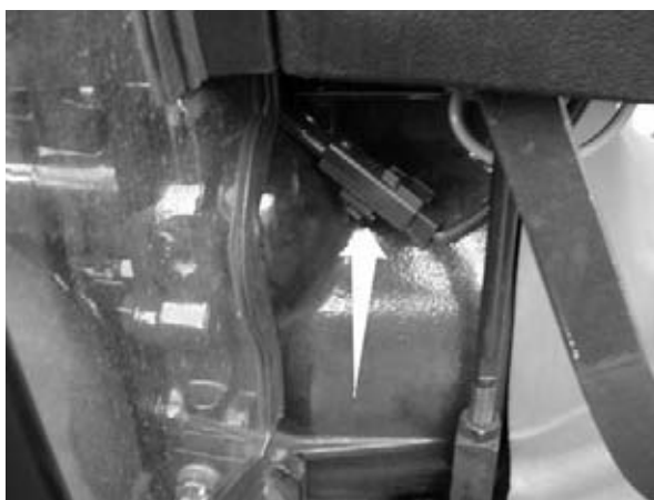
Fusibles de l'installation du démarreur thermique
